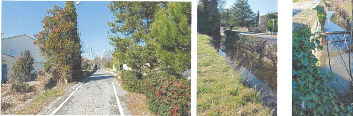
Photos prises au Sud du ponceau actuel et sur l'accotement Est de la voie (localisation des dalots projetés)
